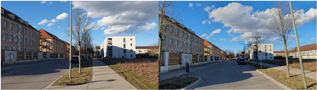
Blick Sommestr. Richtung Norden, mit den Bestandsbauten und Flachdach-Neubau
