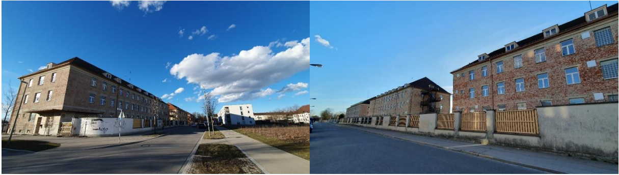
Gebäude mit ehemaligem Wachpostenraum massive und intakte nachhaltige Ziegelsteingebäude
